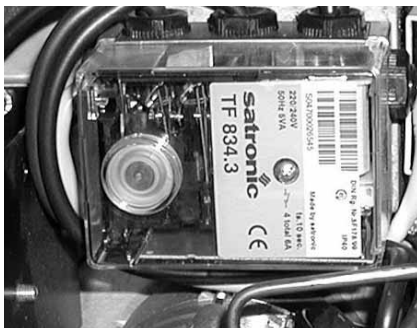
SÖ-NT: Entriegelung des Feuerungsautomaten
