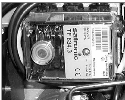
SÖ-NT: Entriegelung des Feuerungsautomaten
