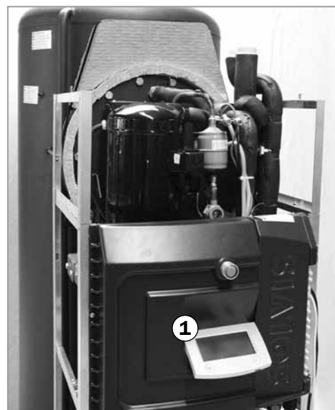
Konsole am Speicher verschrauben
