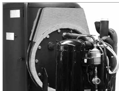
Hintere Flanschisolierung montieren
