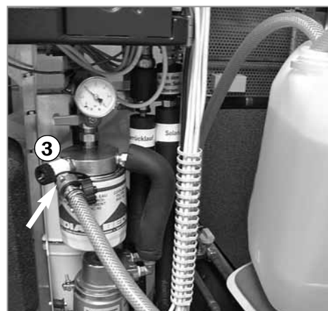
Füllschlauch am Füllhahn anschließen
