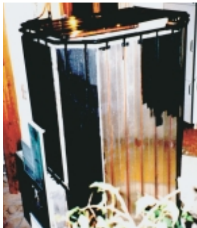
Bild 4: Der Geometrie des Kachelofenkerns entsprechend, wird der Wärmetauscher um den Speicherblock frei aufgestellt und die Vor- und Rücklaufleitung mit den Sammelrohren verbunden. Rundherum werden dann die Keramik – Elemente als Außenhülle aufgemauert.
