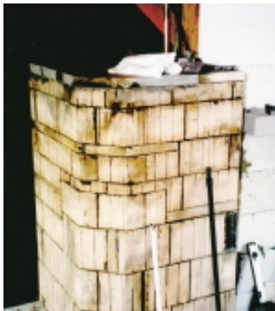
Bild 3: Fertiggestellter Kachelofenkern – wesentlich ist, dass vom traditionellen Grundofen bei dieser Bauart des Kachelofens nicht abgegangen werden muss.
