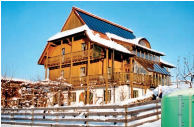
Haus mit Kachelofen-Ganzhausheizung mit Solarunterstützung
